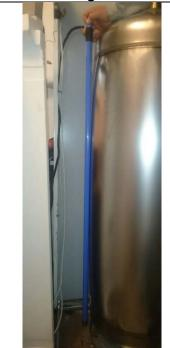
DHW tank deformation
